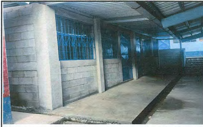
Foto 2: Vista del modulo 6. finalización de remozamiento
