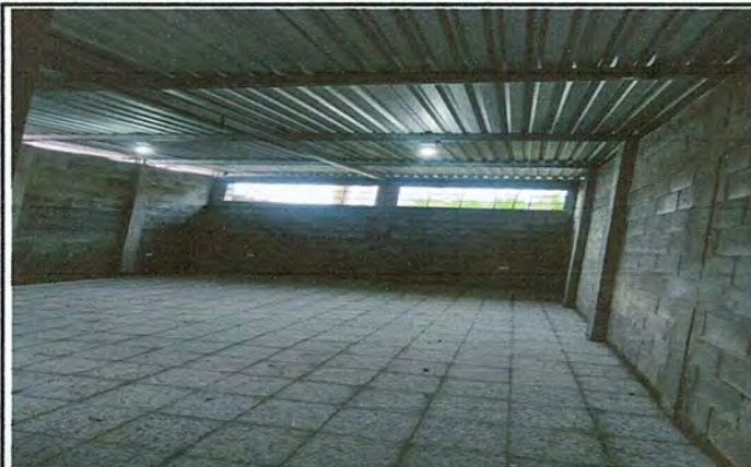
Foto 1: Interior de aulas.
